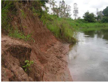
Photo 1 : Erosion des berges à Bopa
